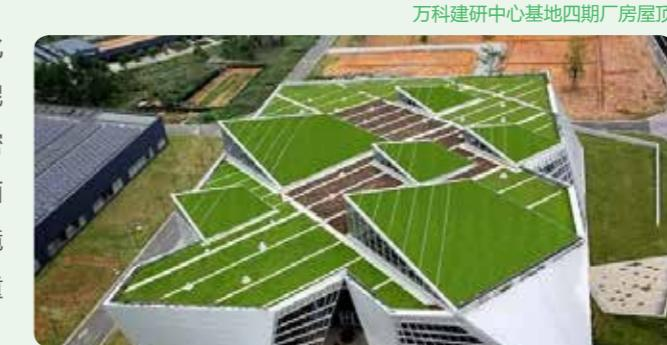
万科建筑研究中心顺势而为，研发出“预制”轻型屋顶绿化产品：屋顶绿化无土复合种植草毯。这种草毯依次由过滤棉阻根层、保湿层、过滤棉固根层、轻基质及草五部分组成，具有施工便捷、成效快、荷载轻、耐高温、耐贫瘠、免后期养护的特点，能起到美化、隔热、防渗漏、节能减排的作用，适用于住宅、商业、市政配套及厂房等屋顶绿化及墙体垂直绿化。
